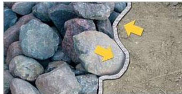
Hohe Bruchdehnung erlaubt, dass das Geotextil sich der noch nicht bearbeiteten Oberfläche der Konstruktion anpassen kann; © Fibertex
